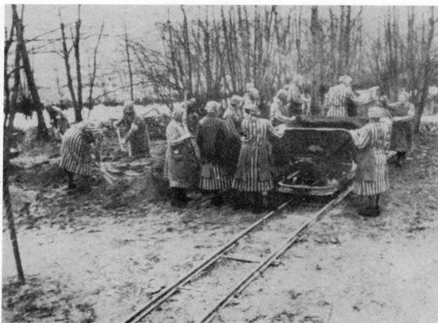
Zeny při zemních pracích v okolí Ravensbrück
